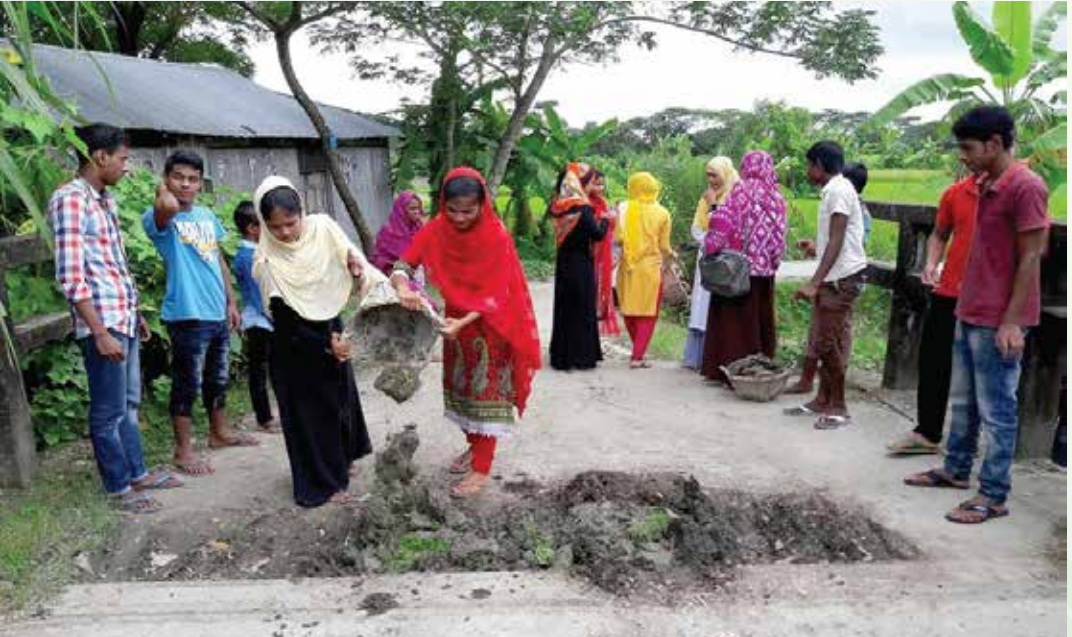
রাস্তা মেরামত। সংস্থা: এসডিআই। ইউনিয়ন: হরিশপুর, সন্দীপ, চট্টগ্রাম
